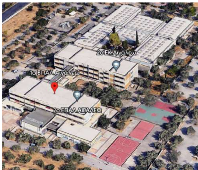
Εικόνα 6.1 Αποτύπωση κτιριακού συγκροτήματος 1 ου ΕΠΑΛ, 2 ου ΕΠΑΛ, 1 ου Εσπερινού Λυκείου, 2 ου ΕΚ Αιγάλεω
