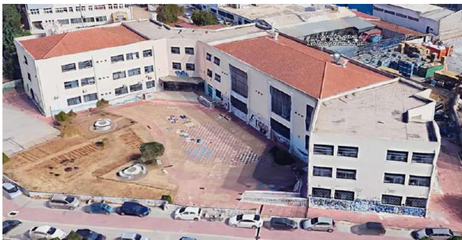
Εικόνα 6.22 Αποτύπωση κτιριακού συγκροτήματος Ειδικού Νηπιαγωγείου – Ειδικών Δημοτικών – ΕΕΕΕΚ
